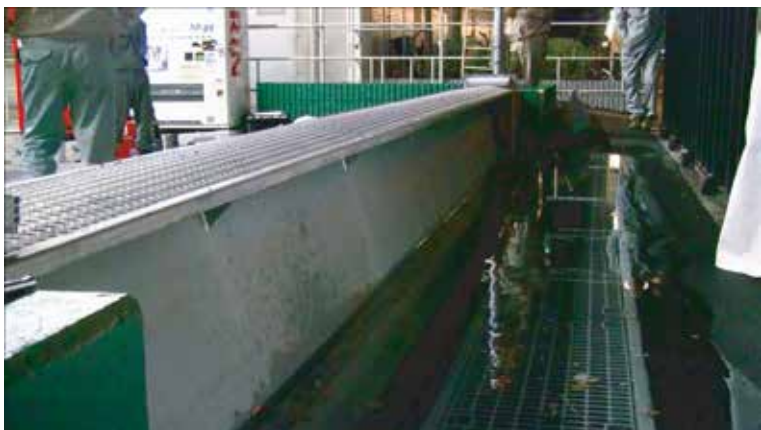
完全止水状況検証 ※営業施設のため夜間検証
